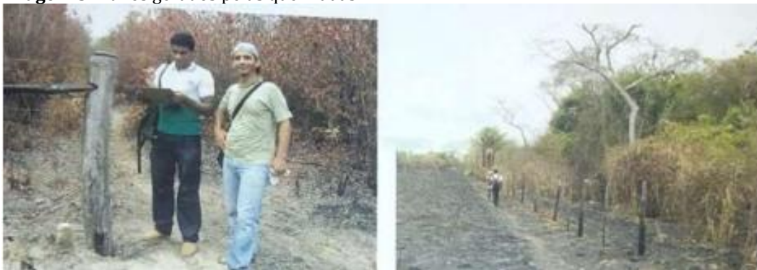
Imagem 3: Danos gerados pelas queimadas.
